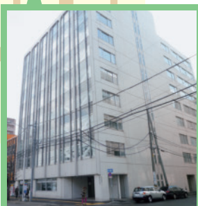
大通バスセンタービル2号館 2階
